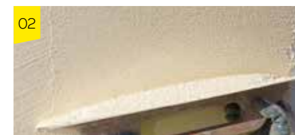
02 Aplicar weberplast decor plus com uma talocha de inox, de baixo para cima, apertando o material de forma a regularizar e nivelar a camada. Passar a talocha nos sentidos horizontal e vertical, até obter uma camada uniforme e sem excesso de material.
