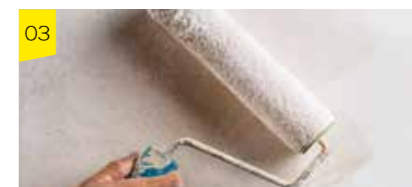
03 Aplicar 2 a 3 demãos, em que a primeira demão pode ser diluída com até 10 % de água na primeira e as restantes diluídas com até 5 % de água. O produto deve ser aplicado usando trincha, rolo anti-gota ou pistola airless .
