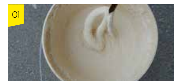
01 Misturar o produto no balde, de forma a homogeneizar os seus componentes.
