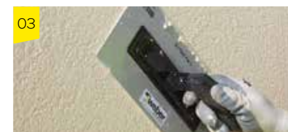
03 Dar acabamento usando uma talocha de plástico, limpa regularmente, em suaves movimentos circulares, verticais ou horizontais, conforme a textura e efeito desejados.
