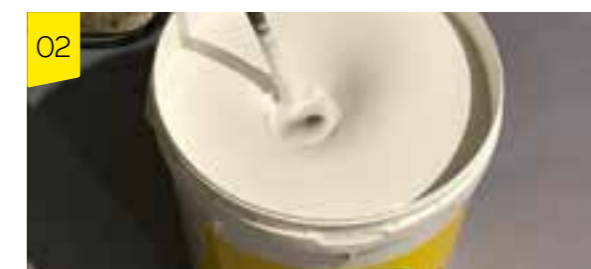
02 Misturar bem o produto com um misturador elétrico de baixa rotação;
