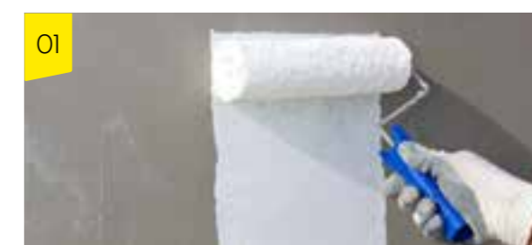
01 Aplicar previamente uma camada do primário weberprim silcolor , com rolo anti-gota;
