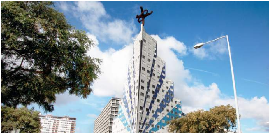
Edifício River Place
