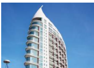
Rede de Frio e Calor do Parque das Nações
