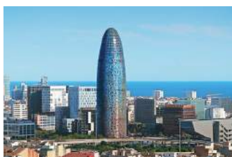
Rede de Frio e Calor
